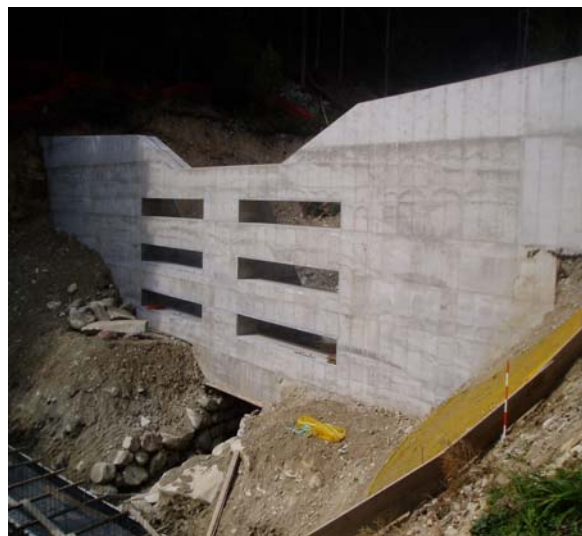
Die neu erbaute Sperre
