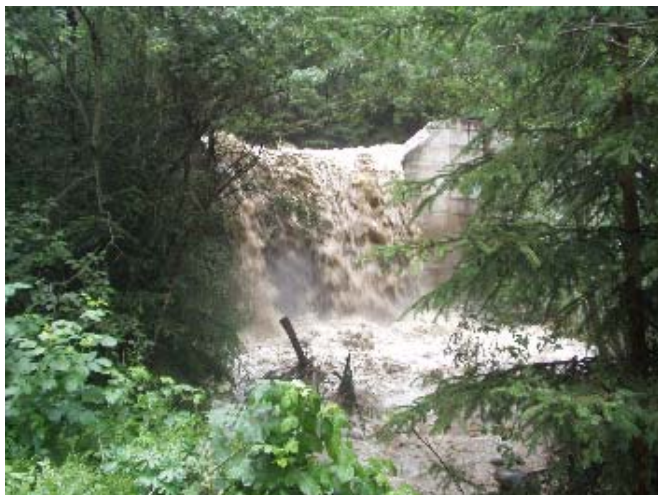
Die alte Sperre nach dem Unwetter
